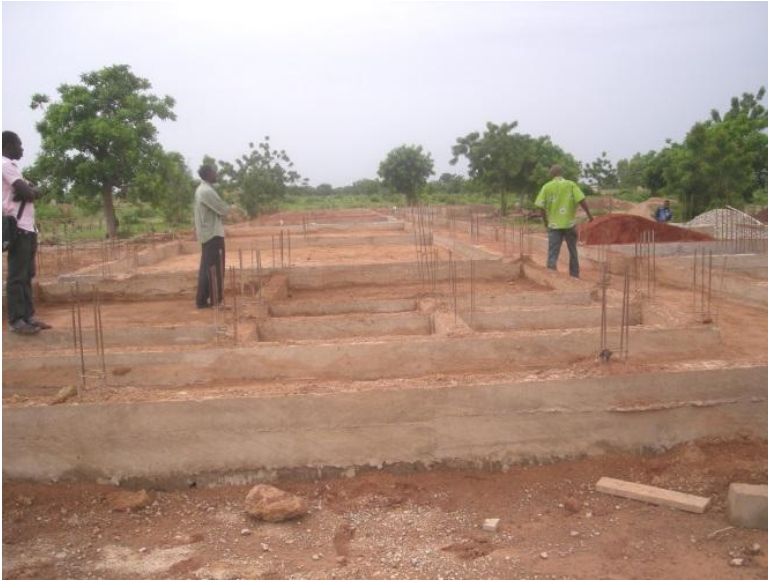
Fundament des Oberstufenschulhauses
