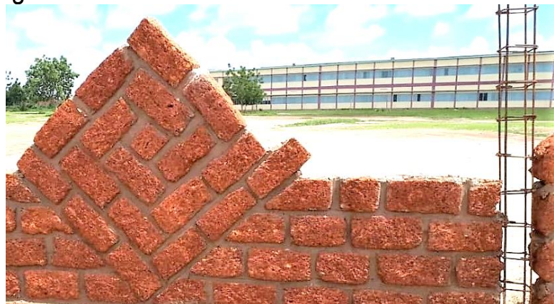
Mauer im Bau, Lycée im Hintergrund
