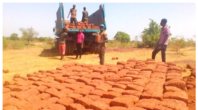
Aus diesen Natursteinen wird die Mauer gebaut.
