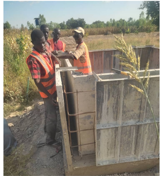
Montage der Schalung für die Betonarbeiten
